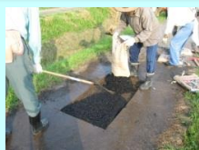
農道の部分補修
