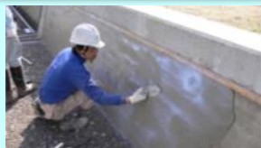
老朽化した水路壁のコーティング
