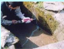
水路のひび割れ補修
